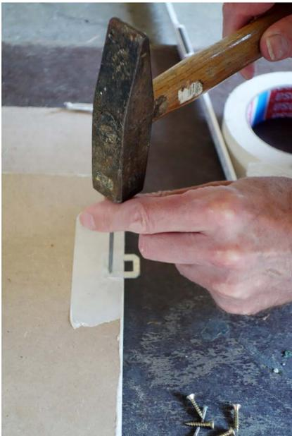
Durch die Schraublöcher der Spiegelbleche mit einem Nagel Vertiefungen für die Bohrlöcher mit einem Hammer leicht einkerben / einschlagen. 2mm reichen
